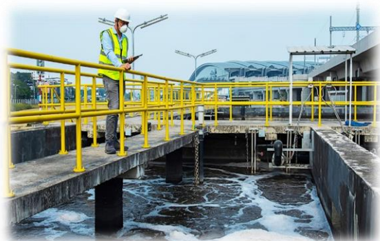
บ่อบำบัดน้ำเสีย
